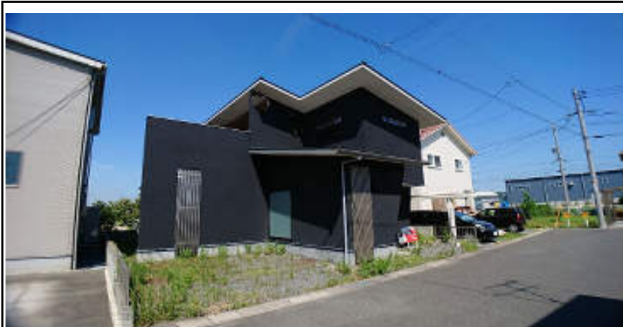
モトーンで落ち着いた佇まいの外観です。 外壁から延びる袖壁が目隠しとなり、お庭がよりプライベートな空間として演出されています。
