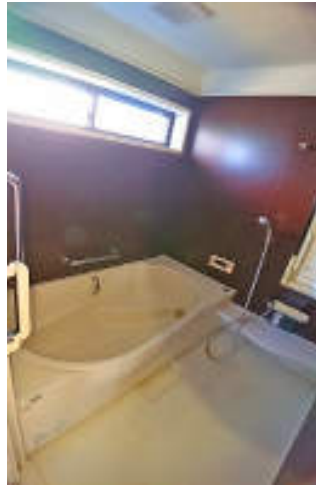
一坪タイプのシステムバス 手すりも完備されたバリアフリーです。
