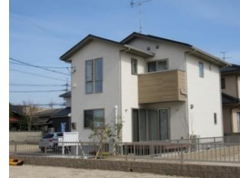
(建物外観:南西から)
